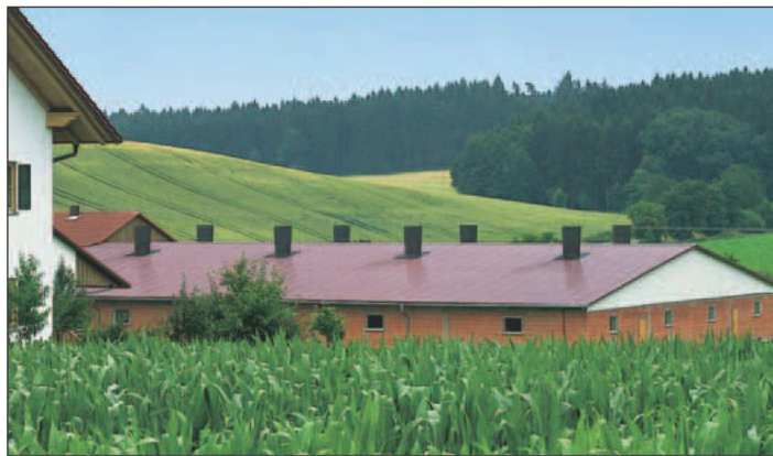
Widok tego samego budynku z zewnątrz
