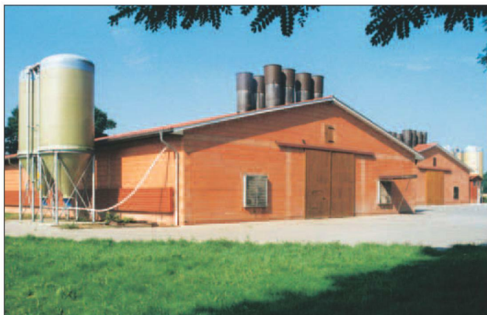
Centralne rozmieszczenie wentylatorów
