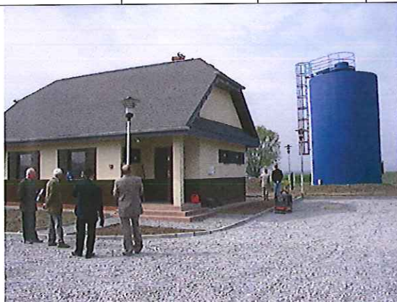
Stacja uzdatniania wody w Łubnicach.
