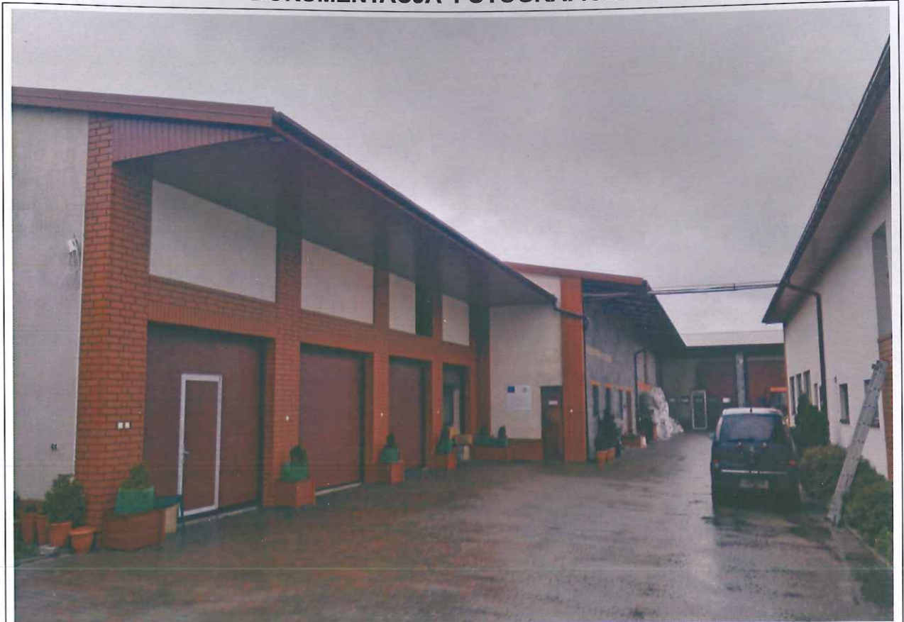
Fot. 3 Widok zabudowy inwestora z budynkiem porodówek na działce nr ewid. 393/3 obr. Dzierzkowice
