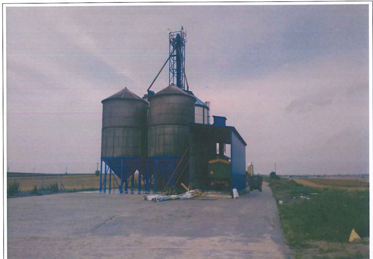
Fot. 4 Widok od południowego-zachodu na istniejący budynek inwentarsko-gospodarczy inwestora na działkach nr ewid. 392/8 i 393/3 obr. Dzierzkowice
